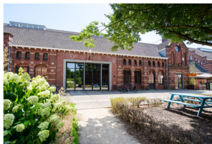
Zuiveringshal Oost, Westergas, Amsterdam Foto: Westergas
